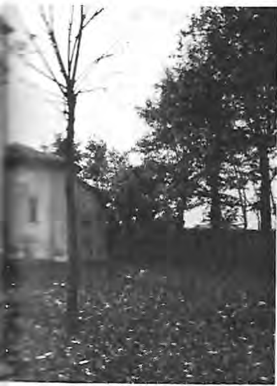
La chiesa dedicata a San Vittore a Rivalta come si presenta dopo i restauri effettuati al tetto
