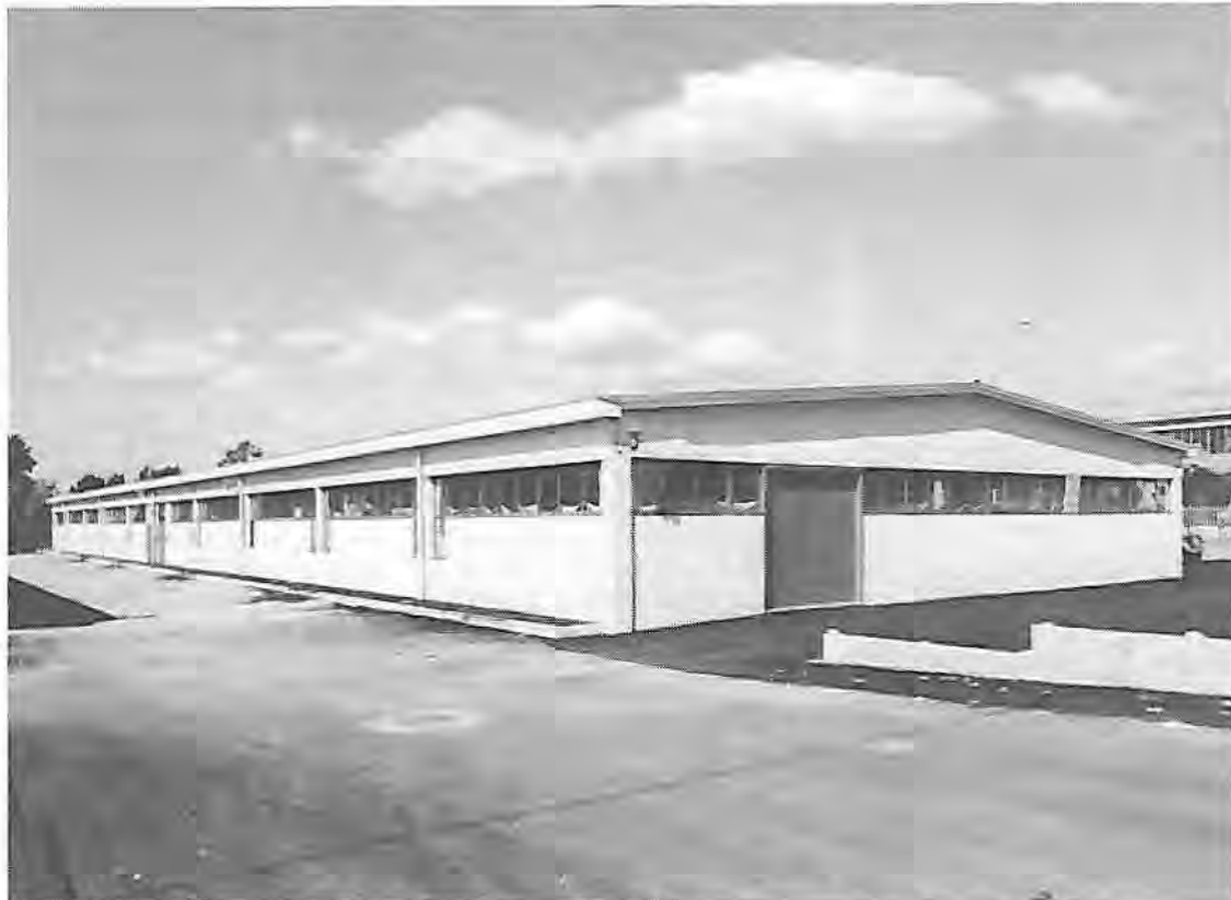
L'edificio che ospita a Gaglianico il Centro handicappati dell'ANFFAS Biella
