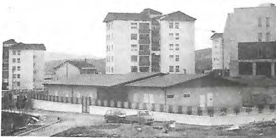
Il Centro per handicappati di Rionero costruito con una spesa di 208 milioni e, in alto, come appare la scuola materna di Avellino
