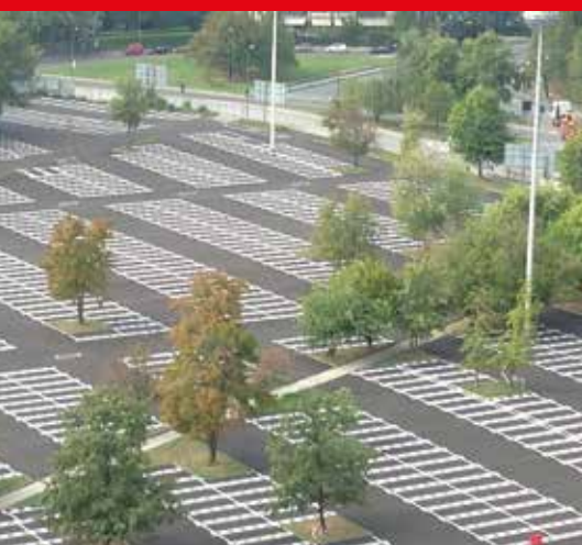
Stadio Meazza Milano - Asfaltatura e segnaletica
