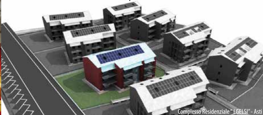
Complesso Residenziale "LGELSI" - Asti
