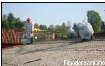
Rimozione amianto
