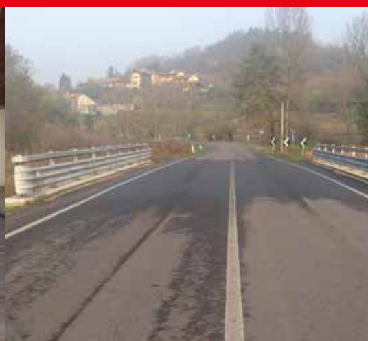
Moasca (AT) SP 6 Realizzazione ponte
