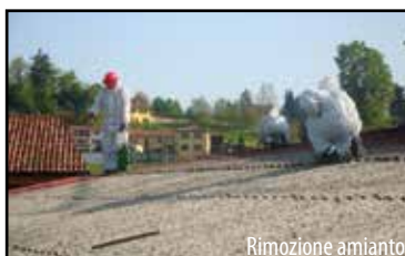
Rimozione amianto
