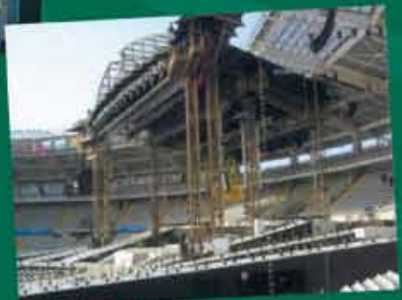
Impianti temporanei stadio olimpico General Electric International
