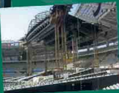
Impianti temporanei stadio olimpico General Electric International
